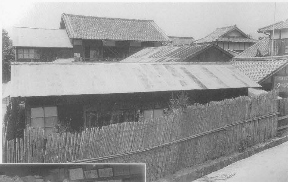
創設時外観（昭和3年当時）
